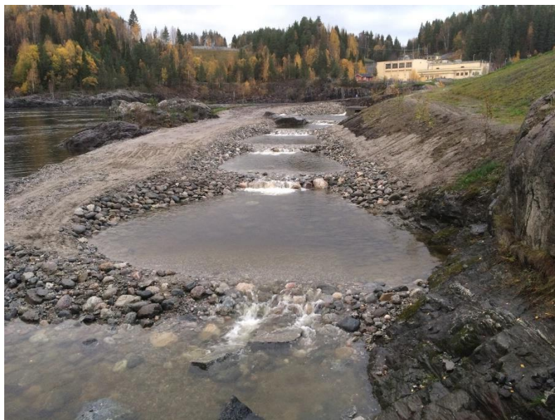
Fig. 11. Eksempel på erstatningsbiotop for gyting og oppvekst av ørret, etablert i forbindelse med utbygging av ny kraftstasjon i Embretsfoss (E4) i Drammenselva
