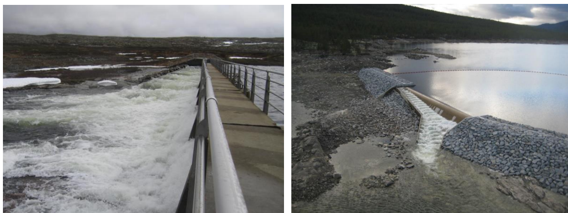
Fig. 17. Eksempel på fisketrapper; til venstre på utløpet av Halnefjorden og ned i Sleipa, til høyre i indre del av Pålsbufjorden ved Rødtjernan. Begge trappene er i Nore og Uvdal kommune
