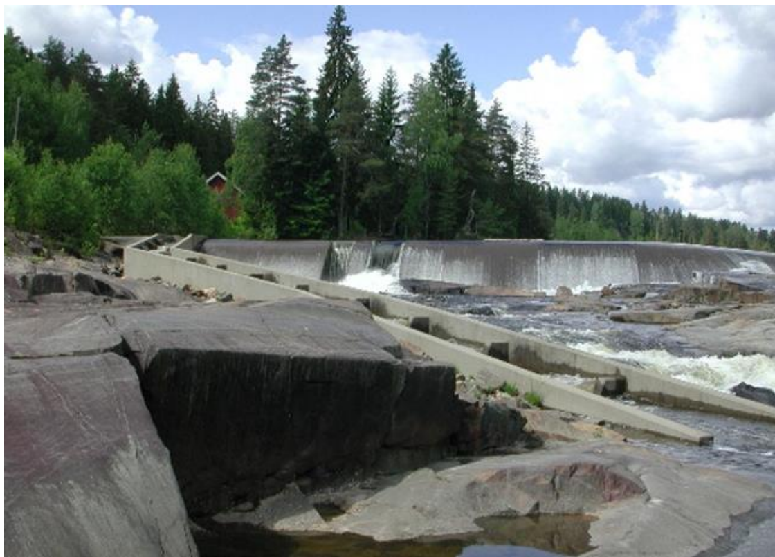
Fig. 18. Fisketrappa ved Labrofoss i Numedalslågen i Kongsberg kommune
