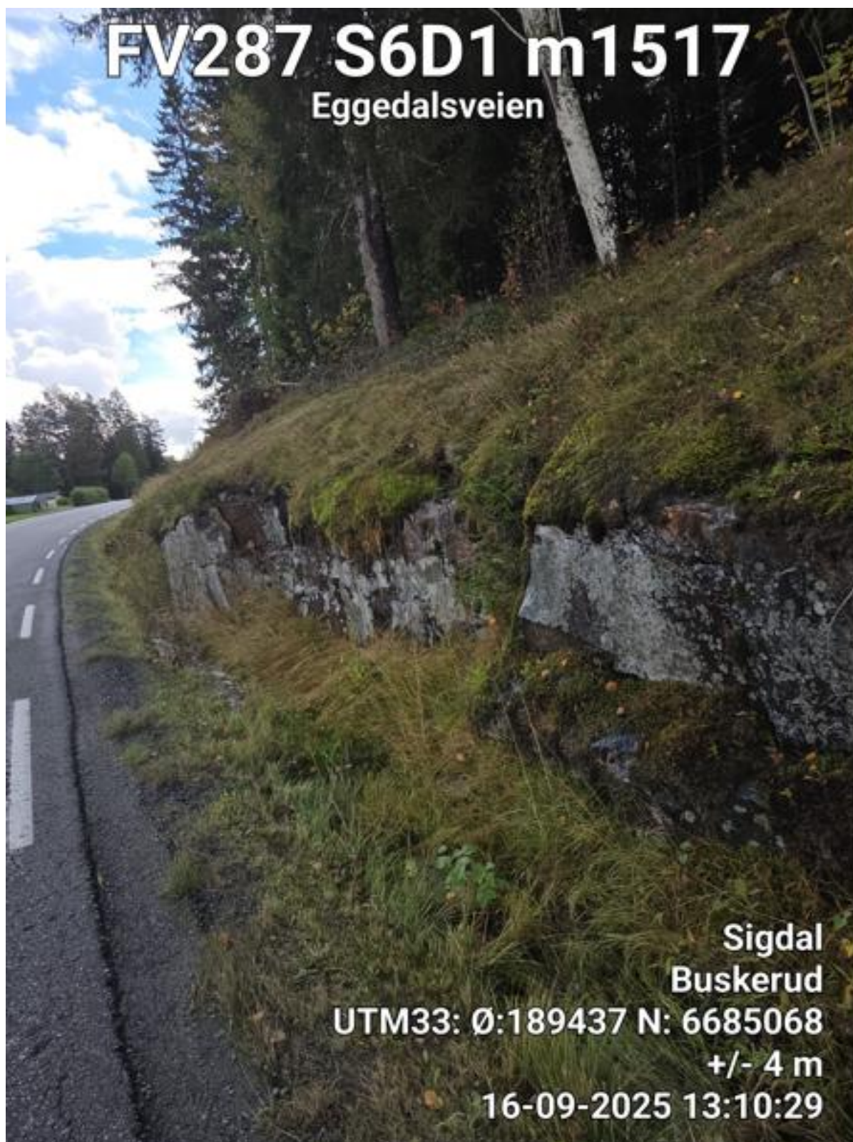
Bilde 19(over); Bergskjæringer / skråninger langs veien som det vil være aktuelle å sprengne seg inn i for å få økt veibredde, eventuelt bedret siktforhold, grøfter og drenering.
