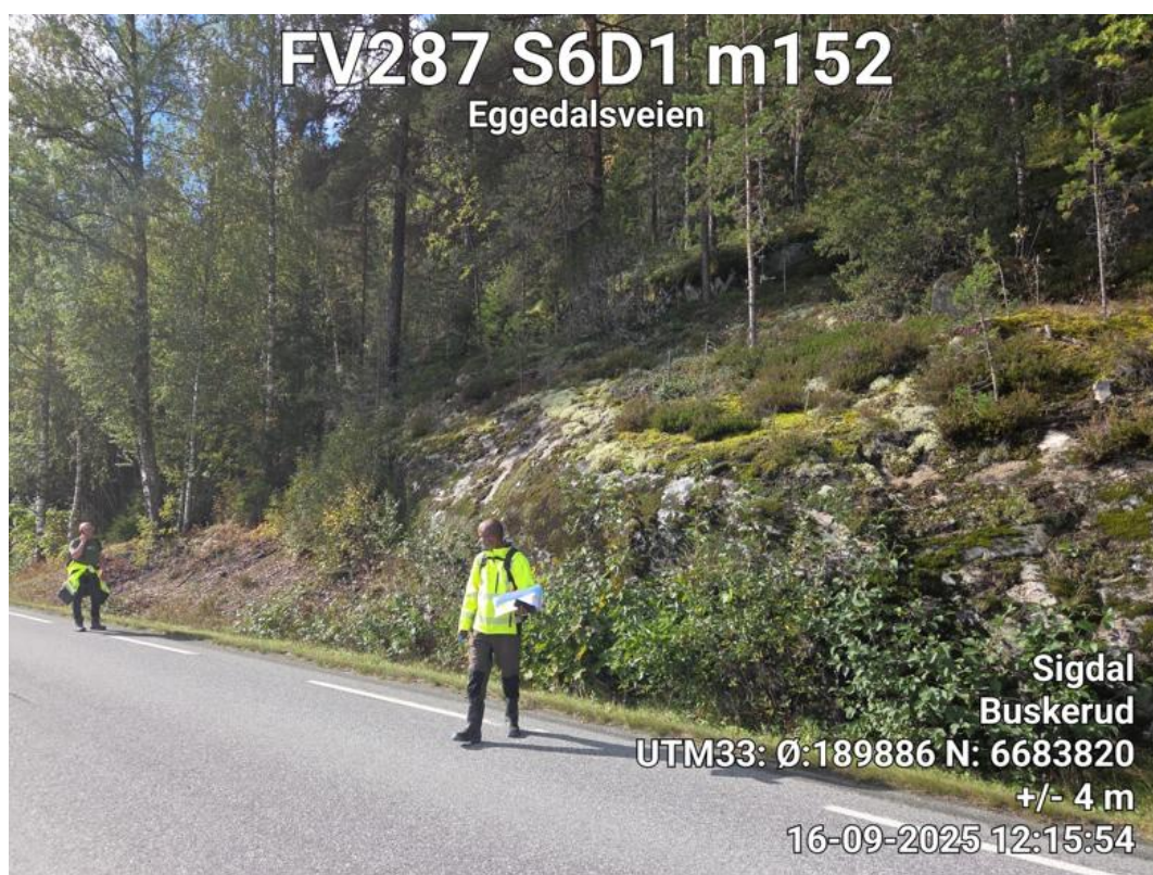
Bilde 13(over) Lave bergskjæringer/ skråninger langs veien som det vil være enkelt å få sprengt seg inn i ved behov.
