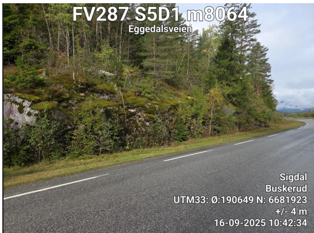
Bilde 2(over): Flere steder langs veien er det lave bergskjæringer med forholdsvis flatt terreng over. Ved behov for breddeutvidelse av veien vil det på slike steder være enkelt å få sprengt seg inn i eksisterende skjæringer / skråninger og etablert nye bergskjæringer.
