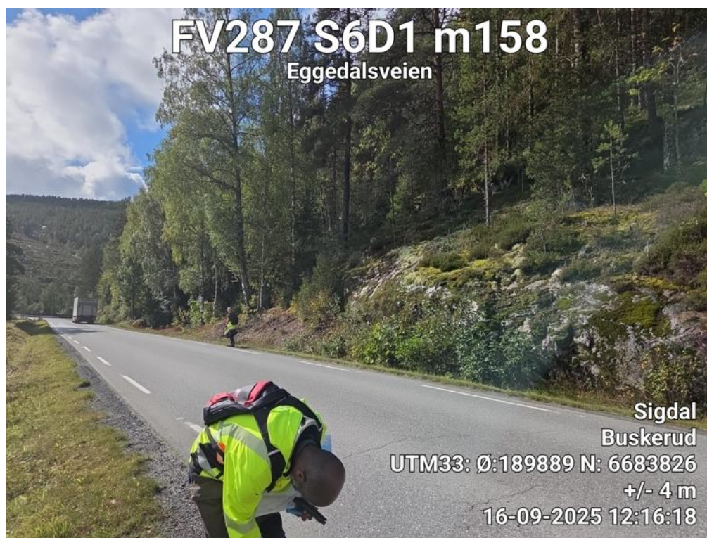
Bilde 15(over): Fra befaringen 16.09.2025. Pågående arbeider med vurderinger av veiens tilstand.
