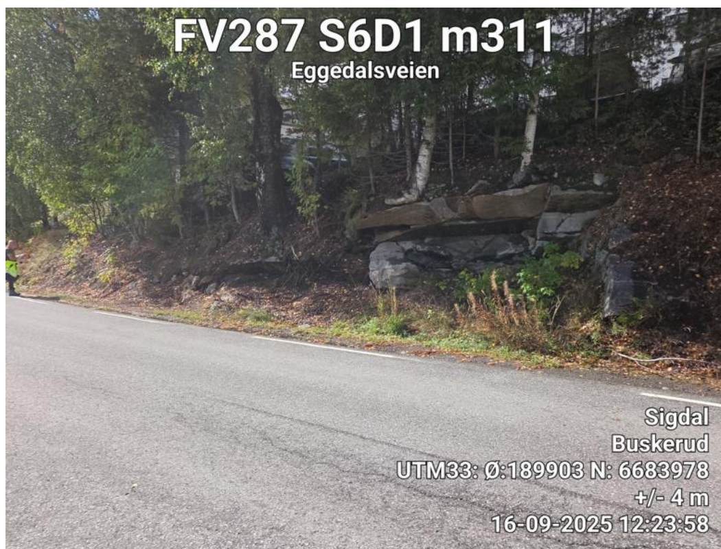
Bilde 16(over): Før oppstart av tiltak med graving og sprengning i veiens sideterreng / skjæringer / skråninger; må det fjernes trær og vegetasjon. Det er også planlagt å etablere noen natursteinsmurer langs veien som sikring mot sideterreng. Disse natursteinsmurene prosjekteres av geotekniker.
