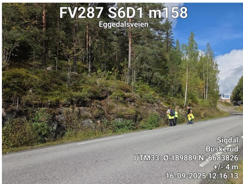
Bilde 14(over): Fra befaringen 16.09.2025. Pågående arbeider med vurderinger av veiens tilstand.
