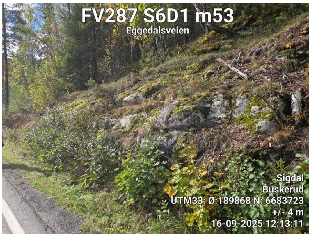
Bilde 12(over): Lave bergskråninger/ skjæringer langs veien. Om nødvendig vil det være enkelt å få sprengt seg inn i sideterrenget for breddeutvidelse, bedret siktforhold og nye grøfter langs veien.
