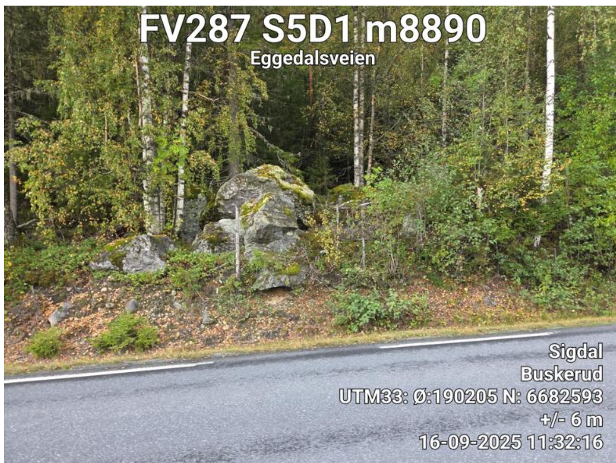
Bilde 7(over): Enkelblokker / bergnabber som ligger tett inntil veien. Berg / bergblokker som enkelt kan fjernes eller flyttes ved behov for etablering av nye grøfter og breddeutvidelse.
