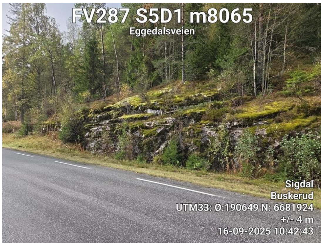
Bilde 3(over): Lave bergskjæringer langs veistrekningen med forholdsvis flatt terreng over.
