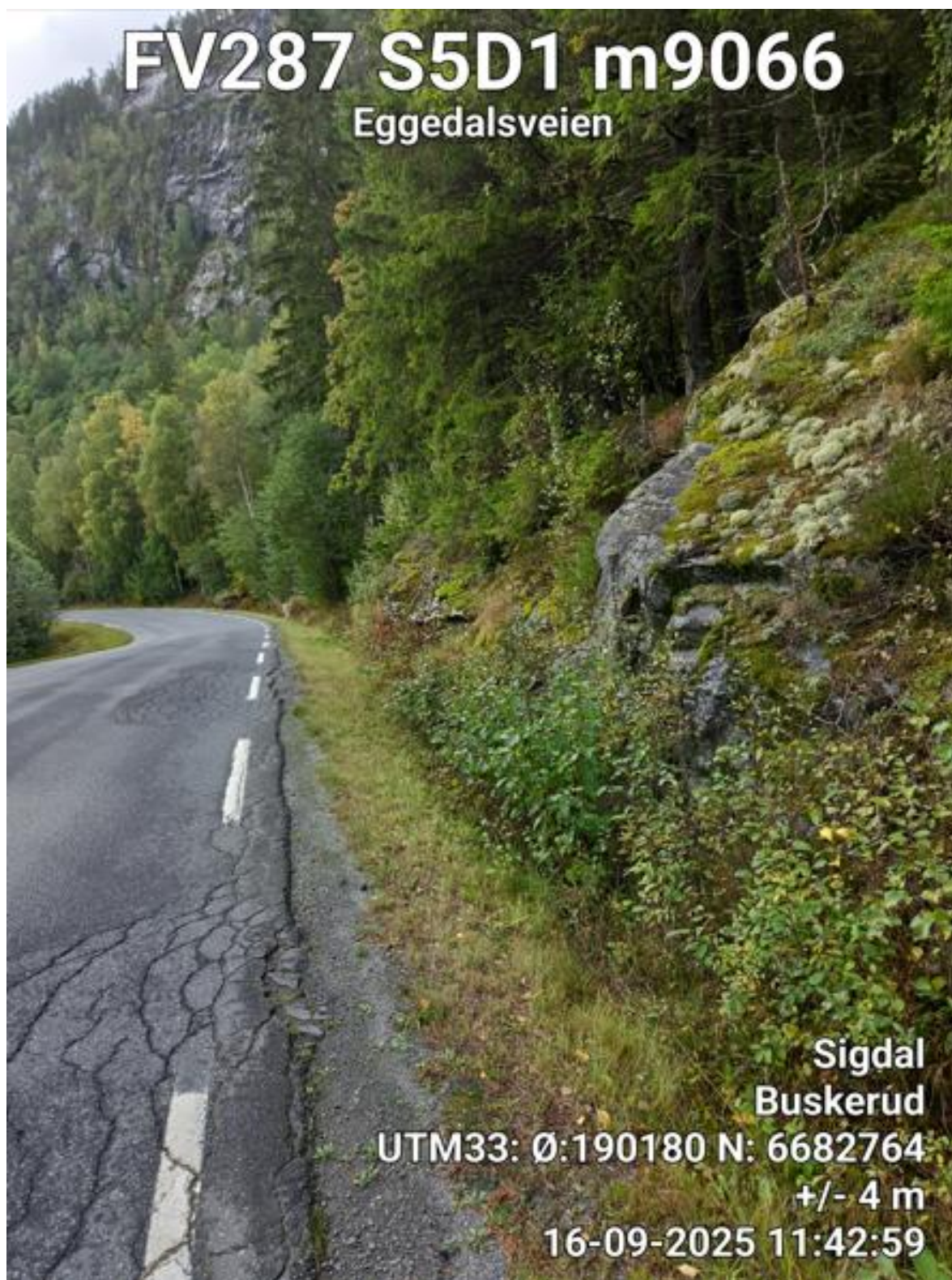
Bilde 10(over): Det er også steder med bratt skrånende terreng ovenfor veien. Ved behov for sikringstiltak må disse tilpasses de ingeniørgeologiske forholdene på stedet. Det er ikke registrert alvorlige skredhendelser på veien (data fra NVDB – Norsk vegdatabank) i området; slik at den generelle skredrisikoen på strekningen vurderes som lav.
