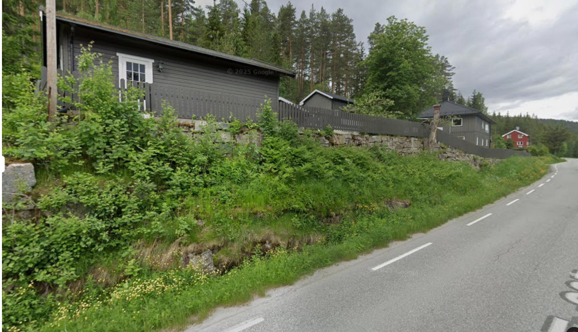
Figur 28 Utsnitt fra Google Street View. Det er etablert en tørrmur over berg i dagen. Bildet er sett mot nordvest.
