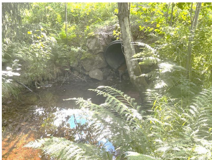
Figur 7-8: Bekk 4, retning oppover bekken. Kulverten under Eggedalsveien kan sees i bakgrunnen.
