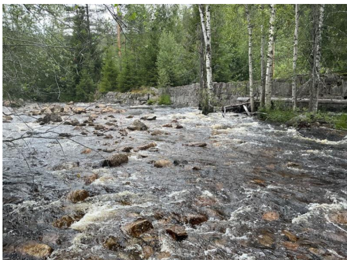
Figur 7-15: Grøn 5, sett oppover elva. Flomsikring i bakgrunn.
