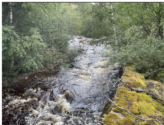
Figur 7-13: Grøn 2, sett oppover elva. Flomsikring synlig på høyre side.
