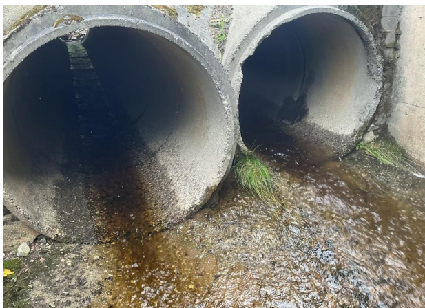
Figur 7-28: Flata 5, nedsiden av veien der bekken renner ut av kulvertene.
