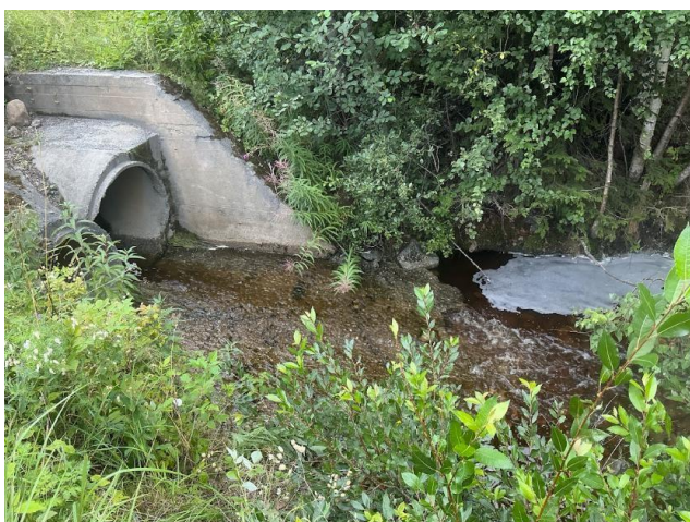
Figur 7-29: Flata 5, nedsiden av Eggedalsveien. Sementbunnen kan skimtes fra kulvertene og nedover mot naturlig bekkedunn.
