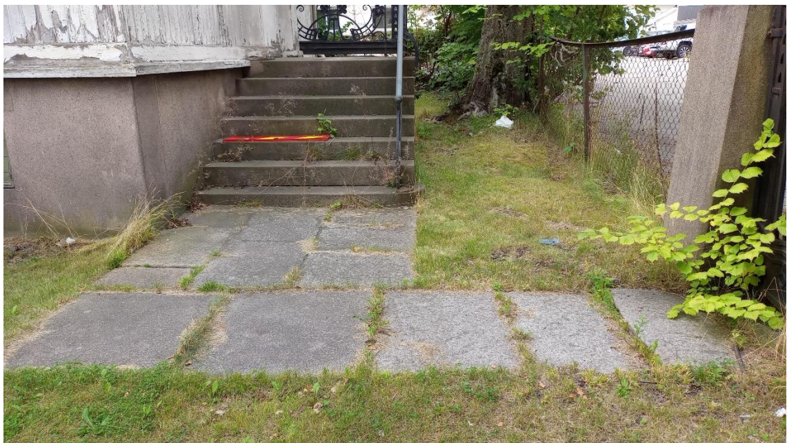
Illustrasjon: Inngang fra Aabys gata. Hellerbelegg, trapp, rekkverk til trappen og innkjøringsport er originale.
